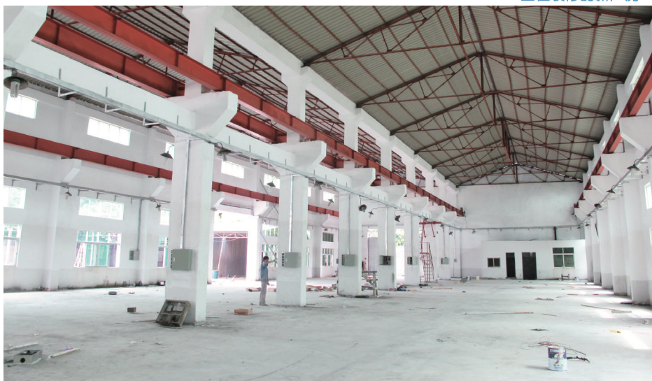
正在装修的新厂房。
