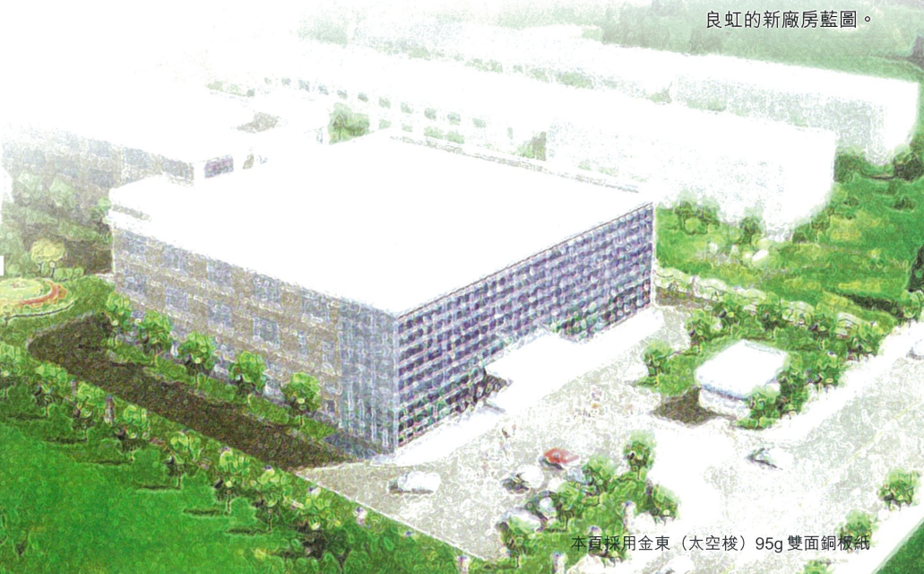
良虹的新廠房藍圖。
